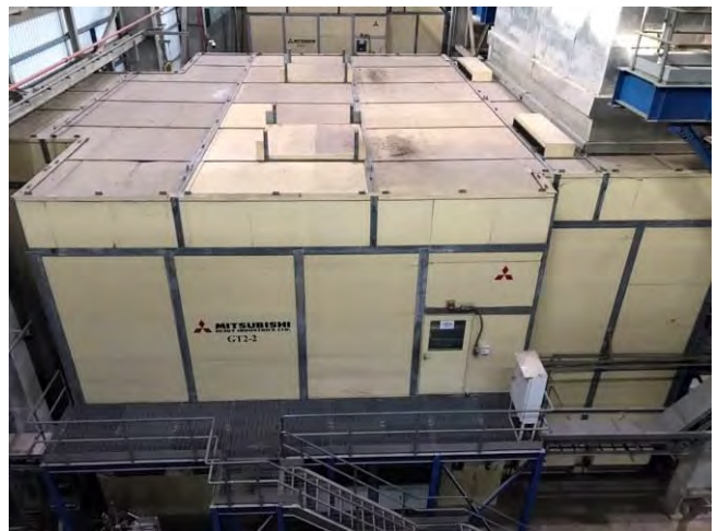
ภาพที่ 2-7 อุปกรณ์/อาคารคลุมเครื่องจักรที่มีเสียงดัง
