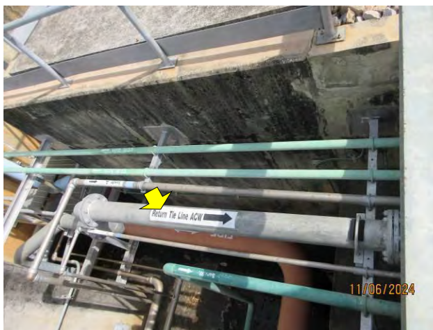
ภาพที่ 2-14 การนำน้ำจาก HRSG Blow down และหอหล่อเย็นที่บำบัดแล้วมายังบ่อน้ำพุ เพื่อการปรับปรุงทัศนียภาพและนำมารดน้ำต้นไม้ภายในบริเวณโรงไฟฟ้า เพื่อลดการทิ้งน้ำออกสู่ภายนอกให้น้อยที่สุด
