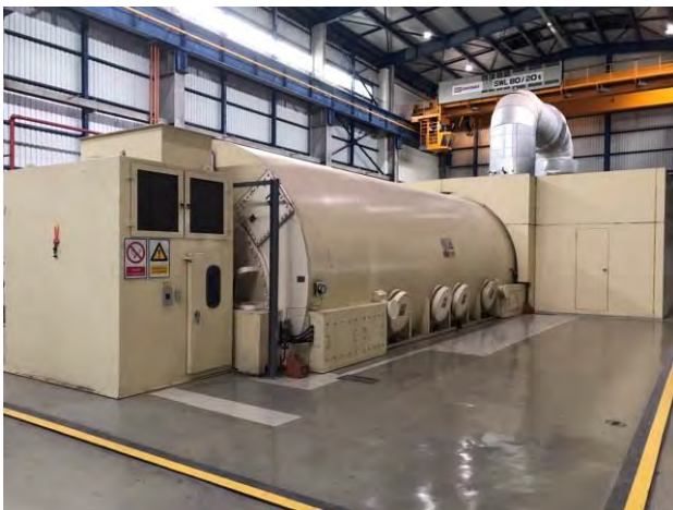
ภาพที่ 2-7 อุปกรณ์/อาคารคลุมเครื่องจักรที่มีเสียงดัง
