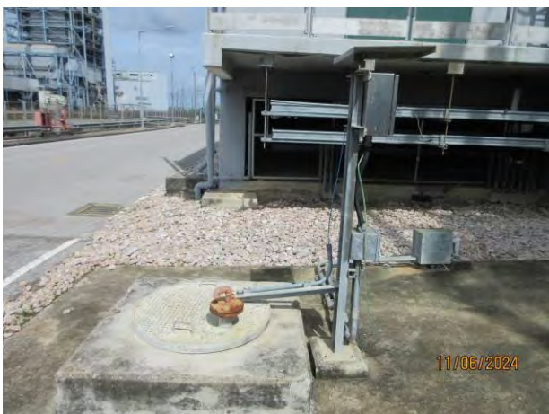
ภาพที่ 2-11 Oil Separator สำหรับแยกน้ำปนเปื้อนน้ำมัน
